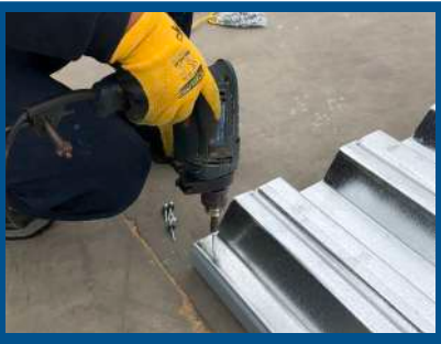
2- Fijación de Plancha Multi-Deck
