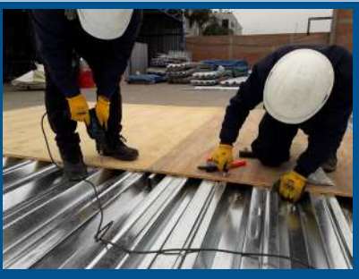
5- Anclaje de Plancha Fenólica
