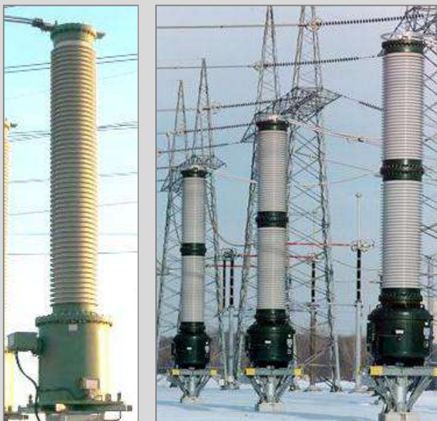
Voltage transformer (VT), e.g. 100 VA
