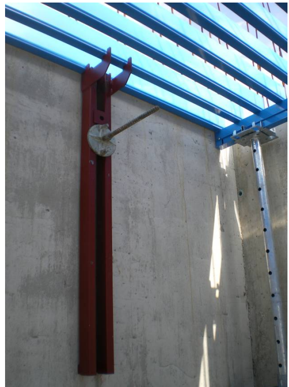
Anclaje de soporte a muro
