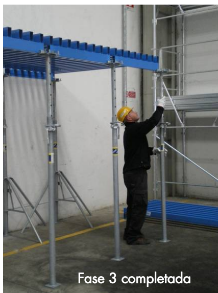
Verificación puesta a plomo puntales
