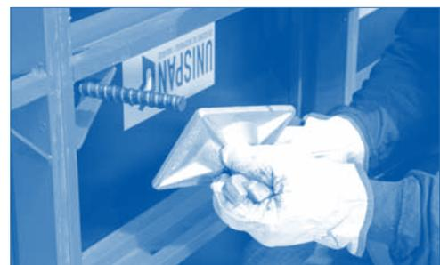
**13.** Una vez que el muro se encuentra fijado por ambas caras se procede a la colocación de los aplomadores, los que se unen al panel mediante el uso de los pasadores.
