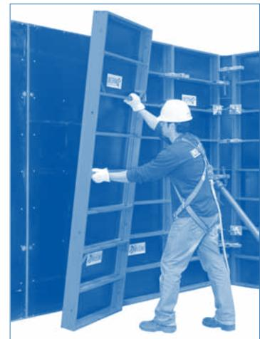
**12.** Colocar las tuercas DUO en los tirantes y apretar de manera de no forzar demasiado, ya que el material plástico puede sufrir deformaciones.
