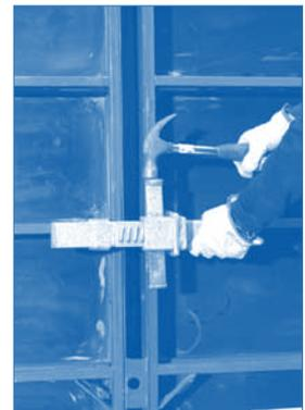
**7.3.** En la utilización de paneles horizontales superiores se debe utilizar el cerrojo alineador, este cumple la función de unir y alinear los paneles inferiores y superiores.
