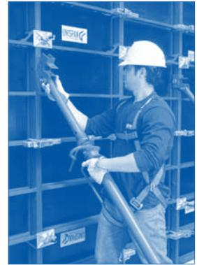
**14.** Complementando el aplomador se debe unir el brazo DUO de manera horizontal, el que se une al aplomador y al panel en su parte inferior.
