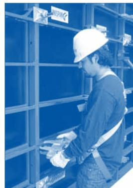
**7.** Los cerrojos tienen la función de unir y alinear los paneles, generalmente se utilizan dos cerrojos en altura en cada unión de paneles. De ser necesaria la utilización de mayor número de cerrojos se indica en el plano de modulación.
