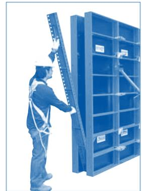
**16.** Para unir la doble canal plegada al panel, se debe utilizar el fijador DUO, el cual se conecta al perfil de panel y presiona la canal hacia el canto del panel. La fijación del panel tapa ALLSTEEL se logra utilizando el regulador tapa DUO.
