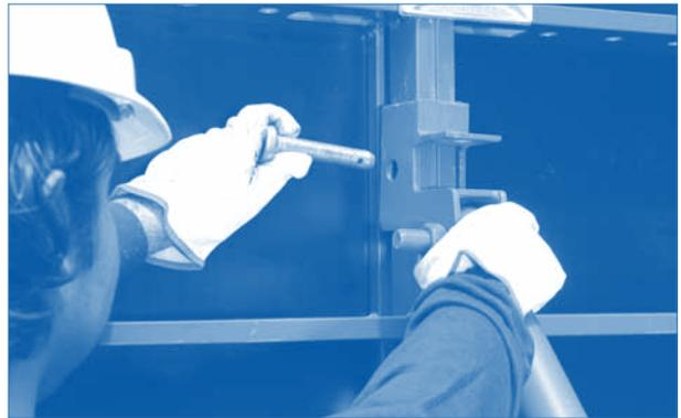
**15.** En los cabezales de muro se deben utilizar paneles tapa ALLSTEEL, los cuales se deben colocar utilizando el regulador tapa DUO y la canal doble plegada.
