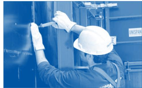
**11.** A medida que el encofrado se va completando y se enfrenta un panel con su contraparte, se debe hacer coincidir el tirante protegido en el panel que se está instalando.
